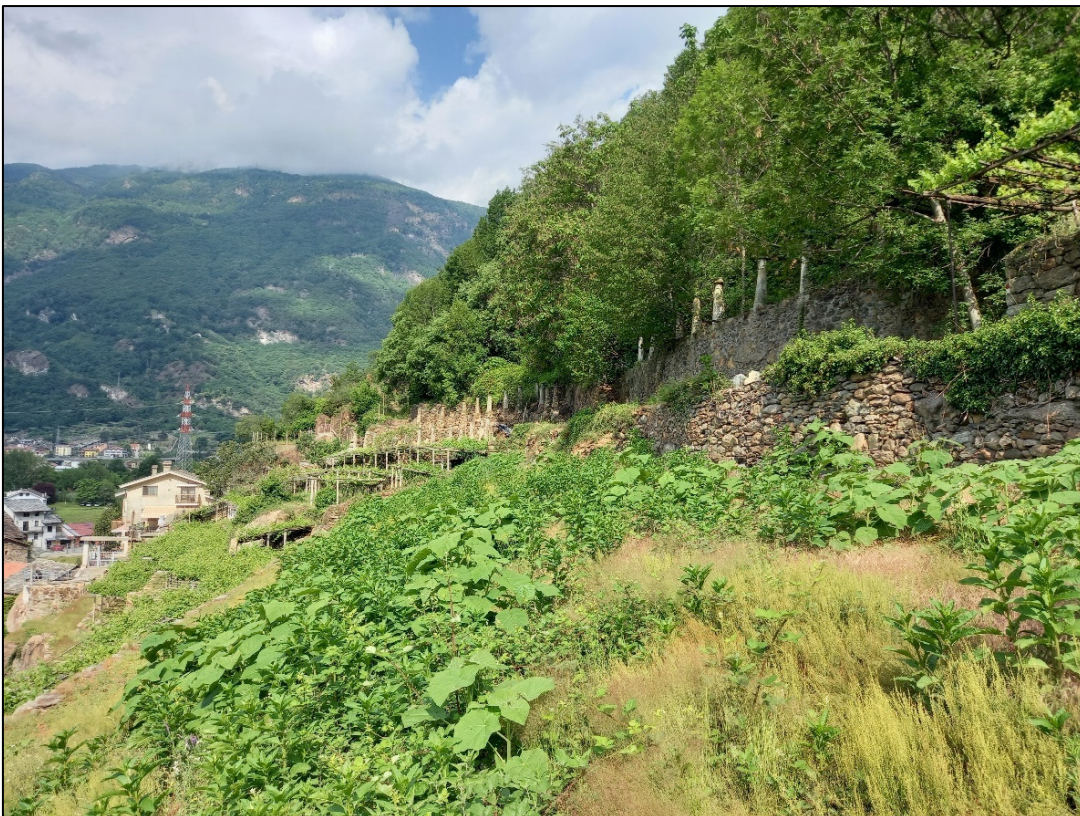
Nota esplicativa: Foto 2. Aree da disboscare e recuperare per conservare l'integrità dei muri.
