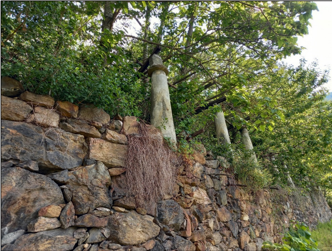
Nota esplicativa: Foto 1. Aree da disboscare e recuperare per conservare l'integrità dei muri.
